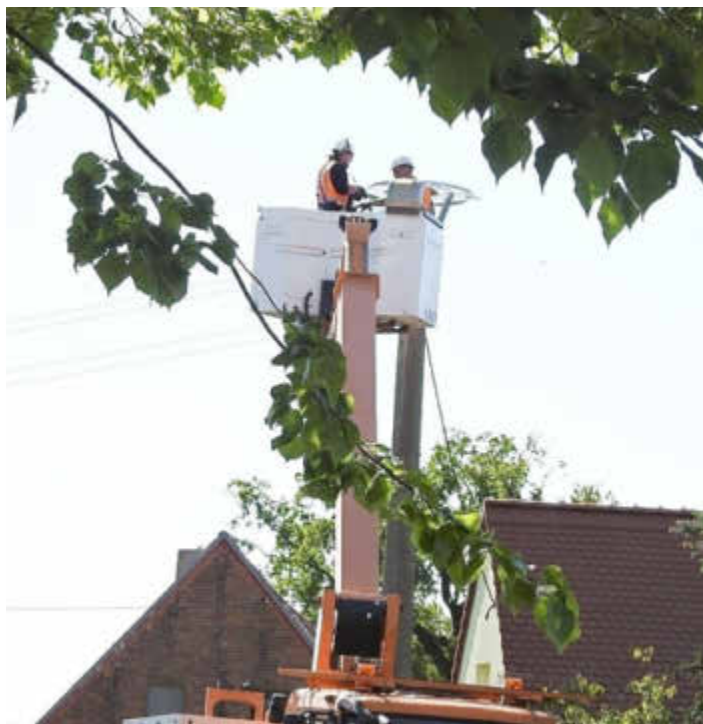
Montage der Nisthilfe am 02.05.2024 durch eine beauftragte Firma der MITNETZ Strom, Anlagenmanagement Köthen.
